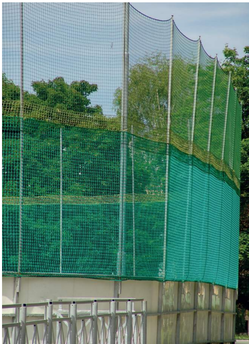
Backstop-nett og beskyttelsesnett på sportsanlegget. Materiale PP; maskestørrelse 45mm, nettykkelse 3, 4 eller 5mm, farge: grønn, svart
