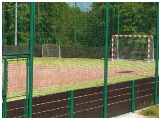
Beskyttelsesnett rundt flerfunksjonell sportsbane. Materiale PE; maskestørrelse 45mm, nettykkelse 3mm, farge; grønn
